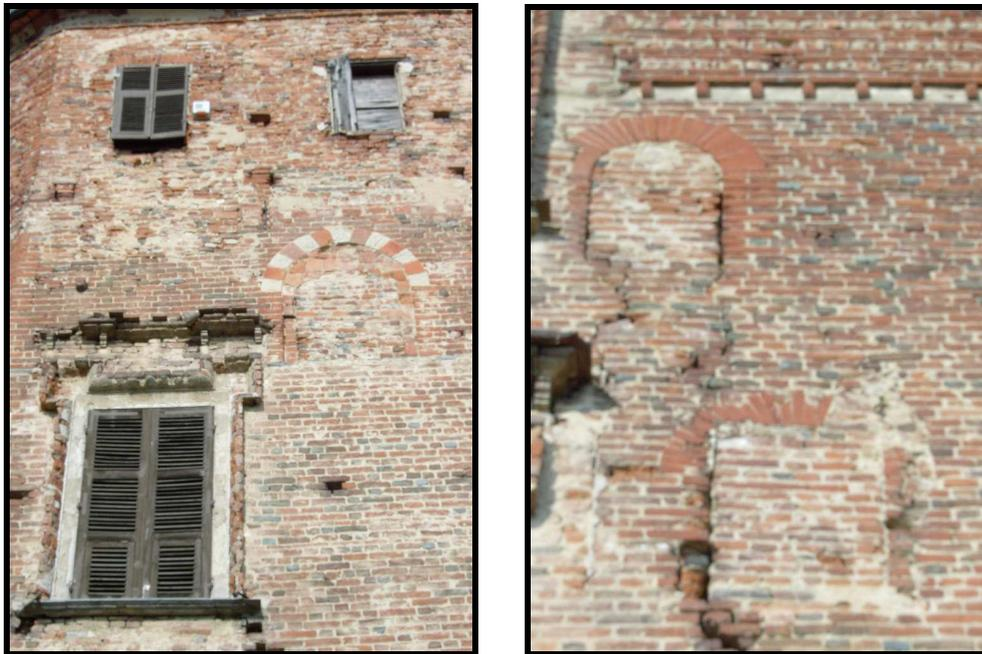
Fig.2-3. Tracce di archi acuti e bicromi ed una cornice a quattro corsi di dentelli del corpo Trecentesco.
