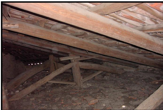
Fig.8-9. Esempi di copertura a capriata della manica Settecentesca ed in primo piano il puntone della copertura alla piemontese del corpo Trecentesco.
