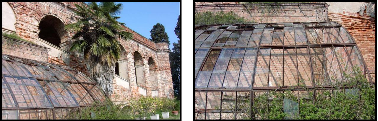
*Fig.11. La serra posta sul lato meridionale esterno del castello, con la caratteristica struttura curva in ferro e vetro.*
